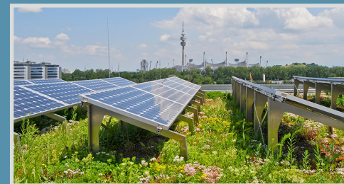
Zonnepanelen met sedumdak
