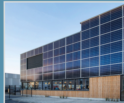
Zonnepanelen aan gevel
