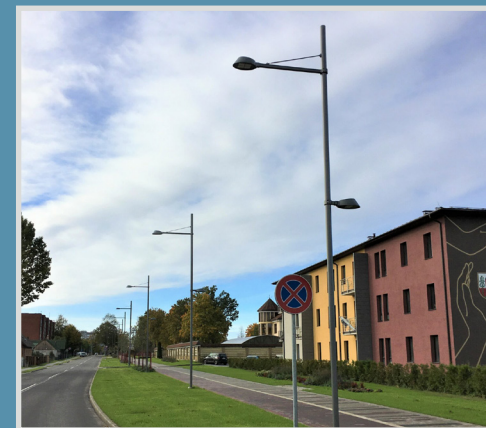
Verlichtingsmasten met armatuur op 2 hoogten
